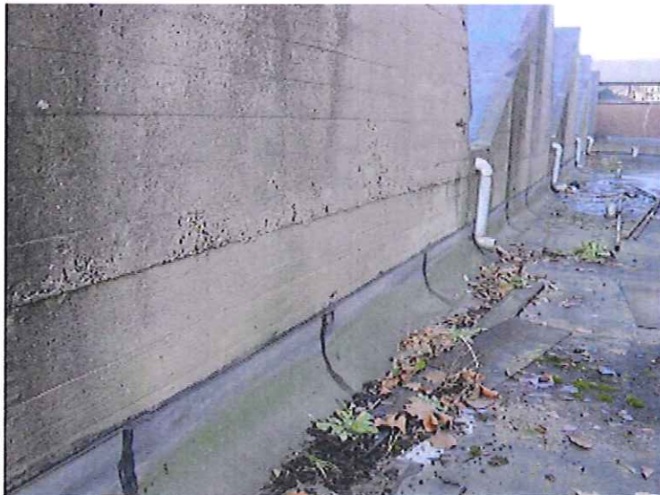
Foto 38 – aansluiting met shedkappen
