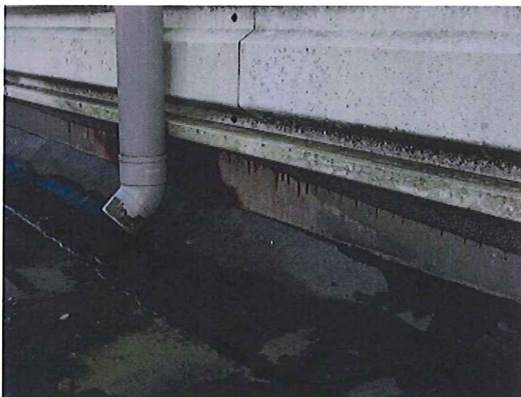
Foto 60 – aansluiting met metalen gevelbeplating
